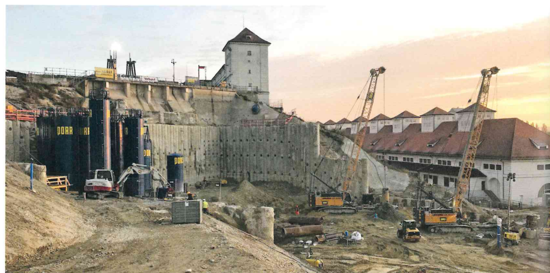
Die Erneuerung des Wasserkraftwerks Töging am Inn, die 2022 abgeschlossen sein soll, ist technisch extrem anspruchsvoll. Im Nahbereich der bestehenden denkmalgeschützten Bausubstanz müssen umfangreiche Spezialtiefbaumaßnahmen gesetzt werden – bis hin zu 70 m tiefen Schlitzwänden.
