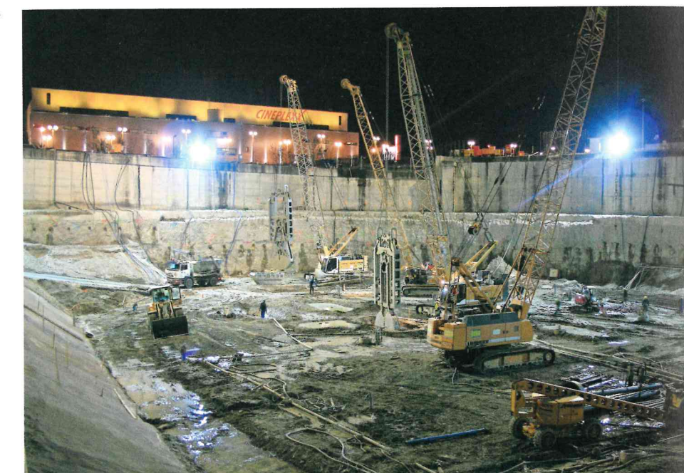
Zwei der zahlreichen Projekte von DI Josef-Dieter Deix: Für den DC-Tower in Wien wurde die Schlitzwand und Schlitzgründung unter der Tertiärwasserhaltung durchgeführt. Im Bild darunter die Save Brücke in Belgrad, die unter der Federführung der Porr verwirklicht wurde.
