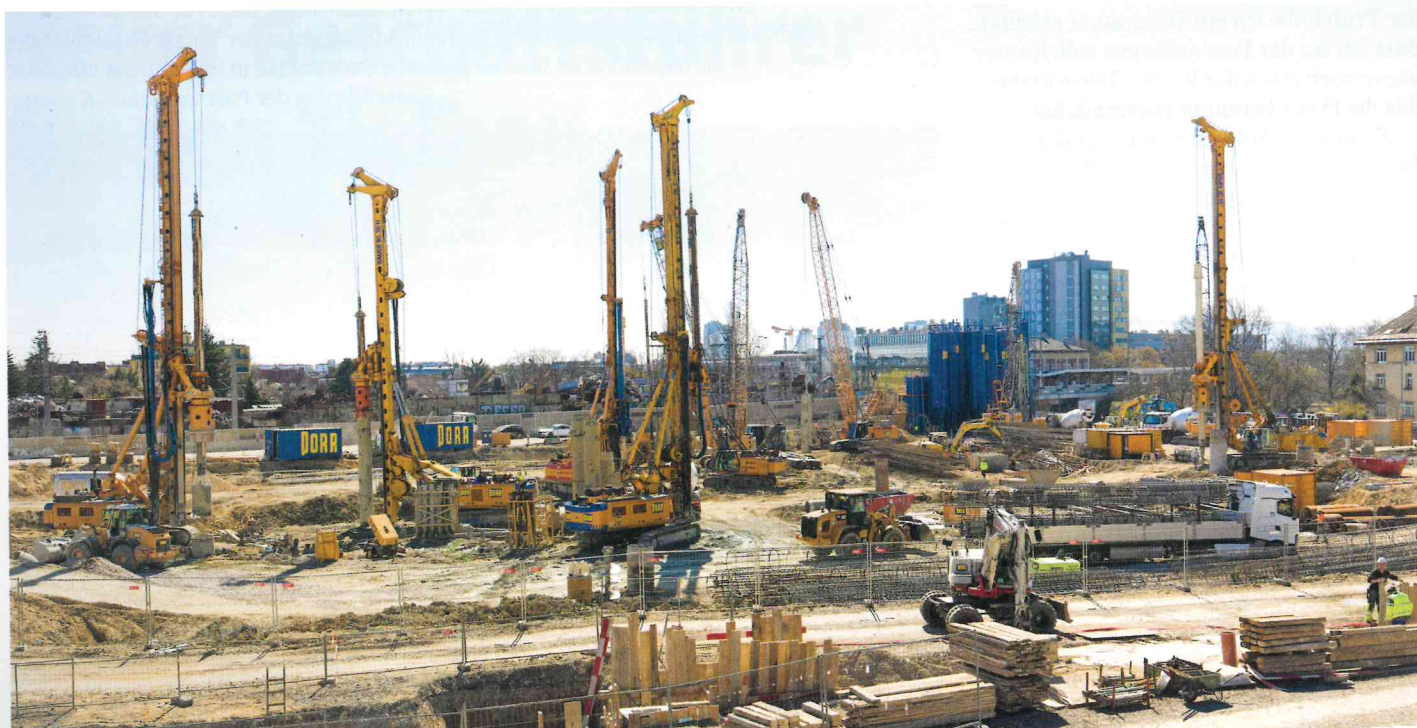
Beim Bau der Biotech-Produktionsanlage des Pharmakonzerns Boehringer Ingelheim in Wien-Meidling musste auf die konstruktiven Tiefbaumaßnahmen spezielles Augenmerk gelegt werden, da unterhalb des Standorts der Lainzer Tunnel mit drei Röhren das gesamte Baufeld quert.
