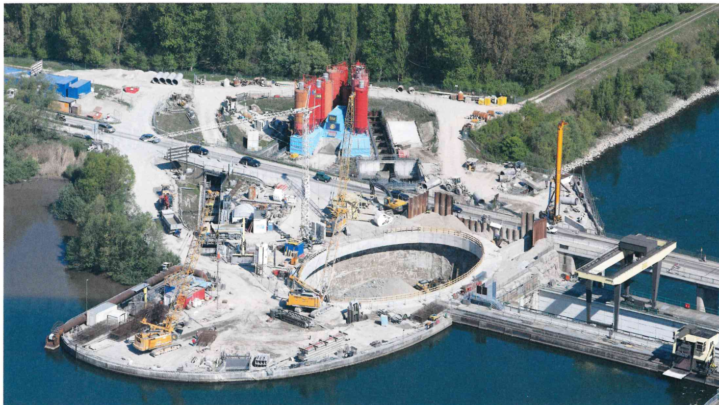
Auch der Bau des Rheinkraftwerks Iffezheim stellte den Spezialtiefbau vor Herausforderungen, unter anderem durch die Errichtung einer elliptischen Baugrube.
